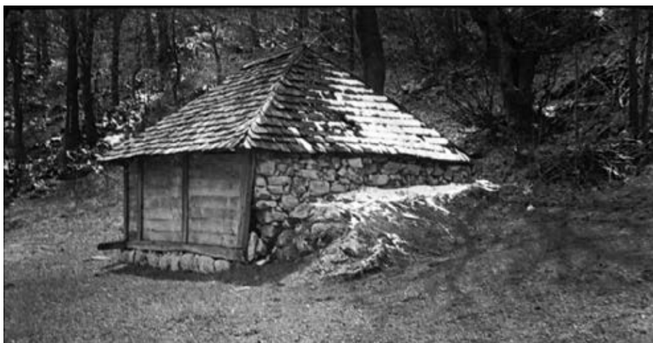
Слика 17. Колиба с ѓланине Повлен (комбинација камена и дрвеѓа) – задњи изглед
