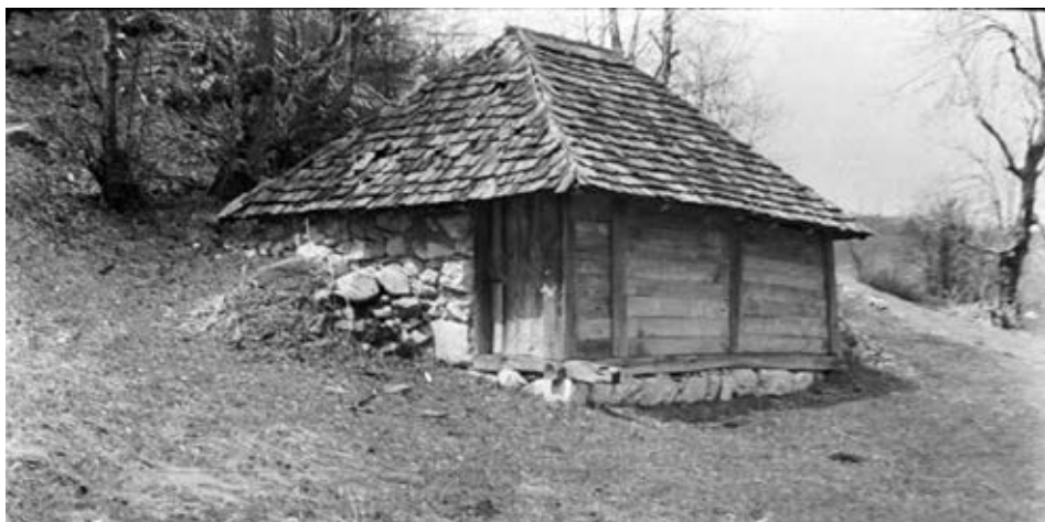
Слика 16. Колиба с ѓланине Повлен (комбинација камена и дрвеѓа) – ѓредњи изглед
