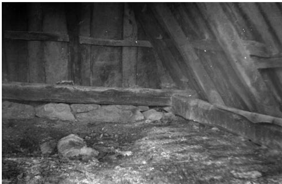
Слика 11. Кулача сложене констїрукције (кулача) на Повлену – констїрукција при тїлу
