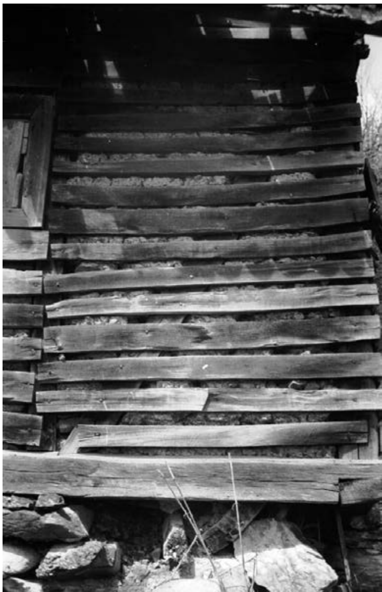
Слика 22. Колиба с ѓланине Повлен (констирукција „на ѓриковце”) – констирукција зида
