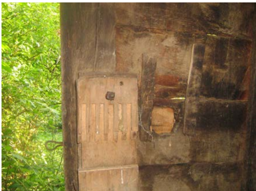
Слика 29. Воденица у селу Скаавци – дејтаљ дрвене кључаонице
