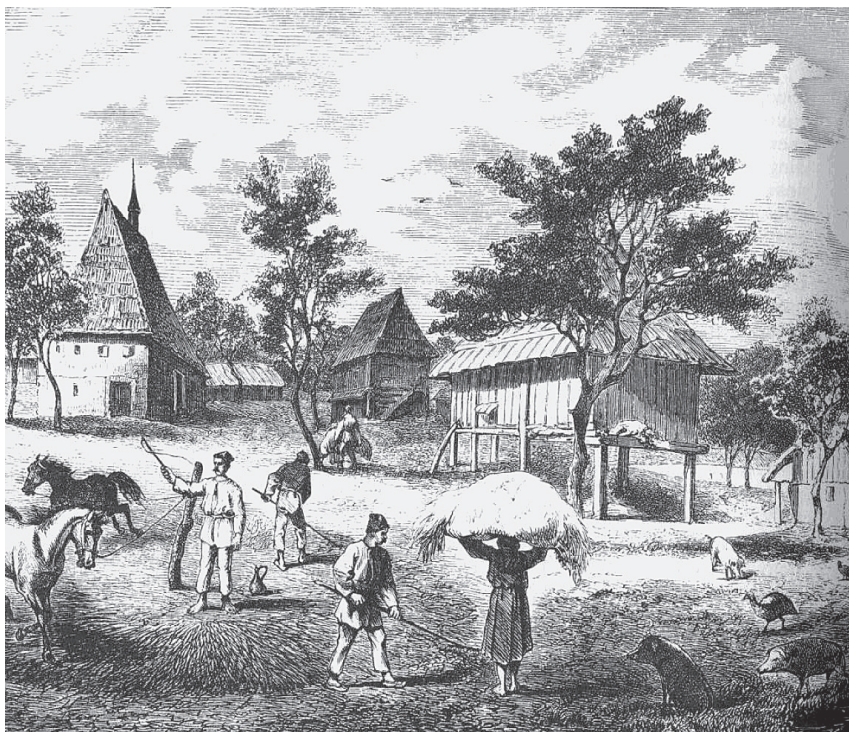
Слика 1. Кош у оквиру сеоског домаћинства у Подрињу. Кош је начињен од скелета од масивне дрвене грађе, високо подигнут изнад коте терена. Испуна је од вертикалних дасака или шашоваца. Кров је на четири воде а покривач дрвена шиндра (крај 19. века). Извор: [Цвијић 1966]
