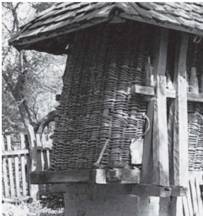
Слика 9. Обруч доњег појаса (једноструки), вертикални елементи (двоструки) и преплет од прућа (збијени слог) на кошу сеоског домаћинства из села Парамуна код Косјерића (1996). Фојто: [Аутор].
