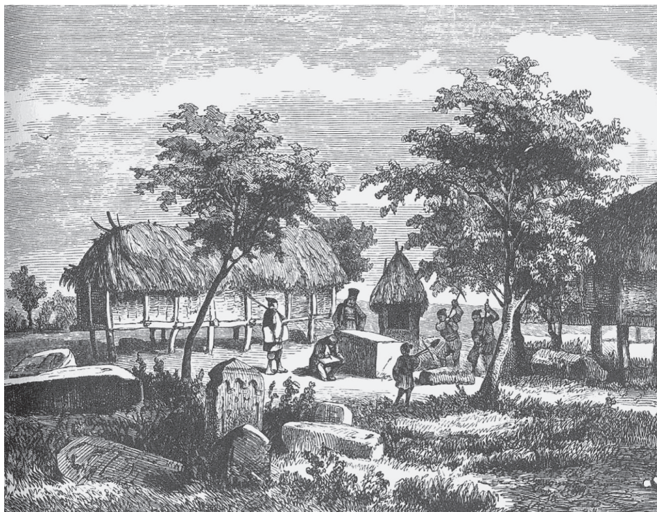
Слика 3. Јавни кош у оквиру некрополе у селу Горобиље код Пожеге. Кош је начињен од скелета од масивне грађе са испуном од преплета од прућа. Кров је на четири воде а покривач је слама притиснута лемезима (друга половина 19. века). Извор: [Каниц 1987].
