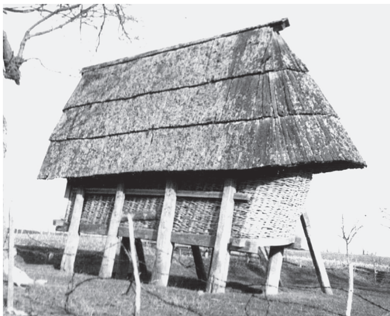
Слика 6. Кош са четири ступца без косника укопаних у земљу са доњим и горњим појасом, са испуном од преплетеног прућа и покривен шиндром. Село Кремна код Ужица (1957). Извор: [Архива Новака Живковића из Ариља].
