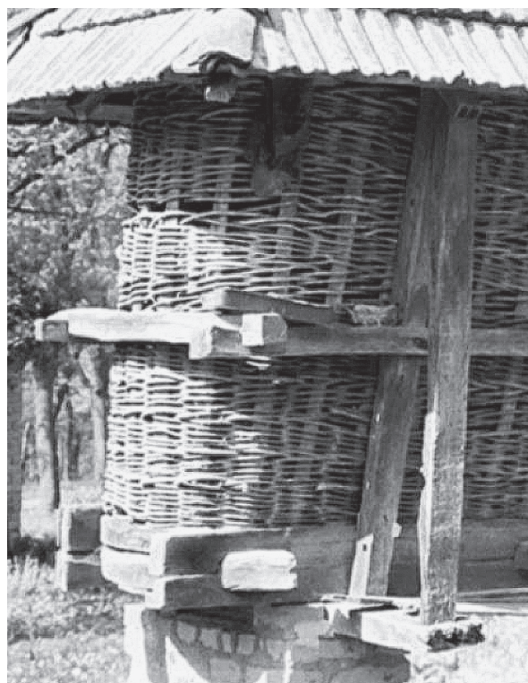
Слика 8. Обруч доњег појаса (двоструки), вертикални елементи (једноструки) и преплет од прућа (ретки слог) на кошу сеоског домаћинства из села Мионица код Пожеге (1996). Фото: [Аутор].
