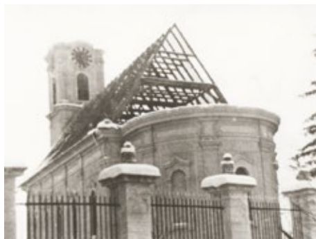
Фотографија 5. Почетак рушења Саборног храма од стране усташа (јануар 1942)
