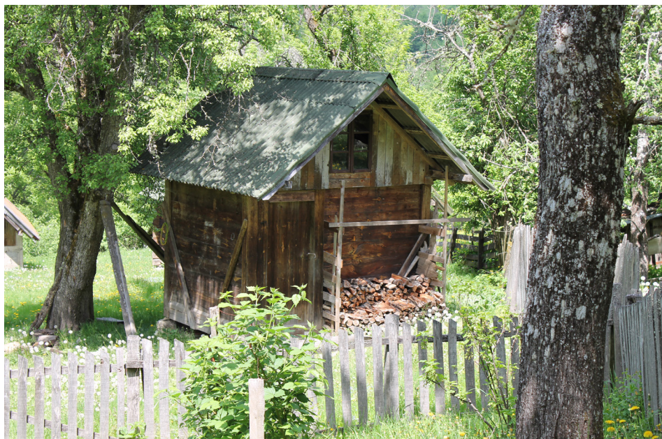
Фото 14. Зграда за смештање ствари и хране, село Растиште (фото: М. Панић)
