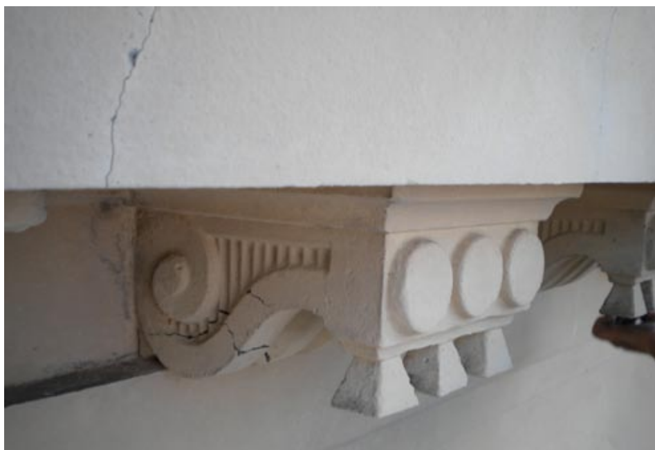
Замена фасадних конзола
