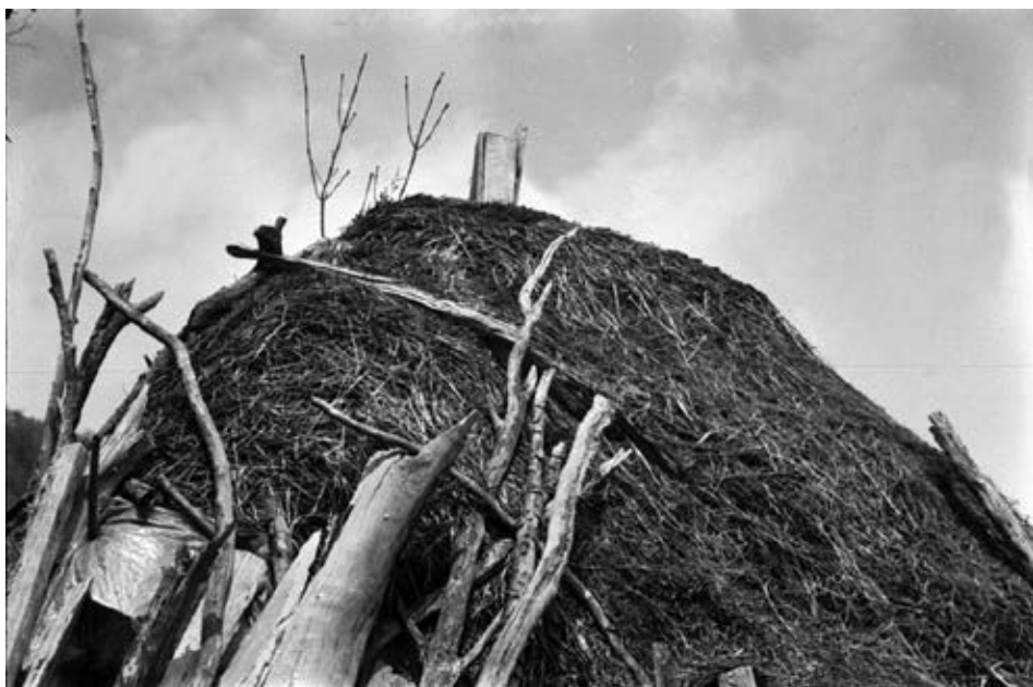
Слика 6. Кулача на Повлену – лемези и оџвор за излаз дима на крову
