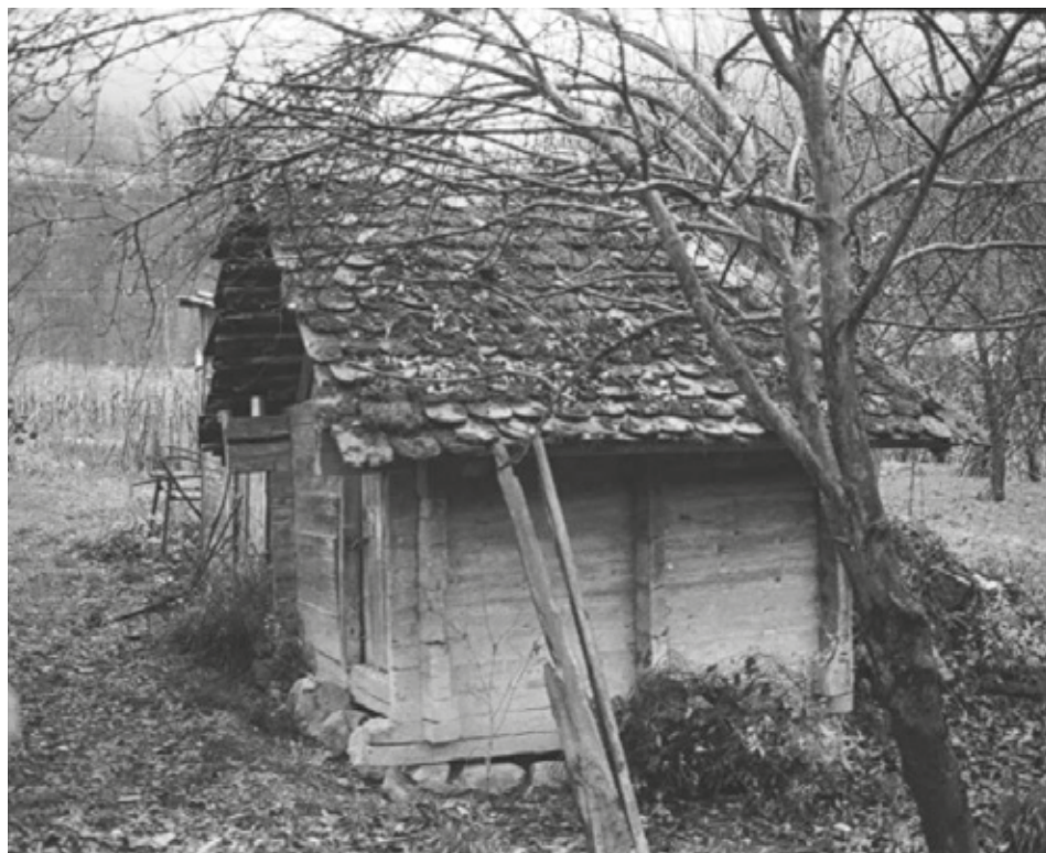
Прилој 26. Амбар од талпи са везом на углу „на ћерџи”
