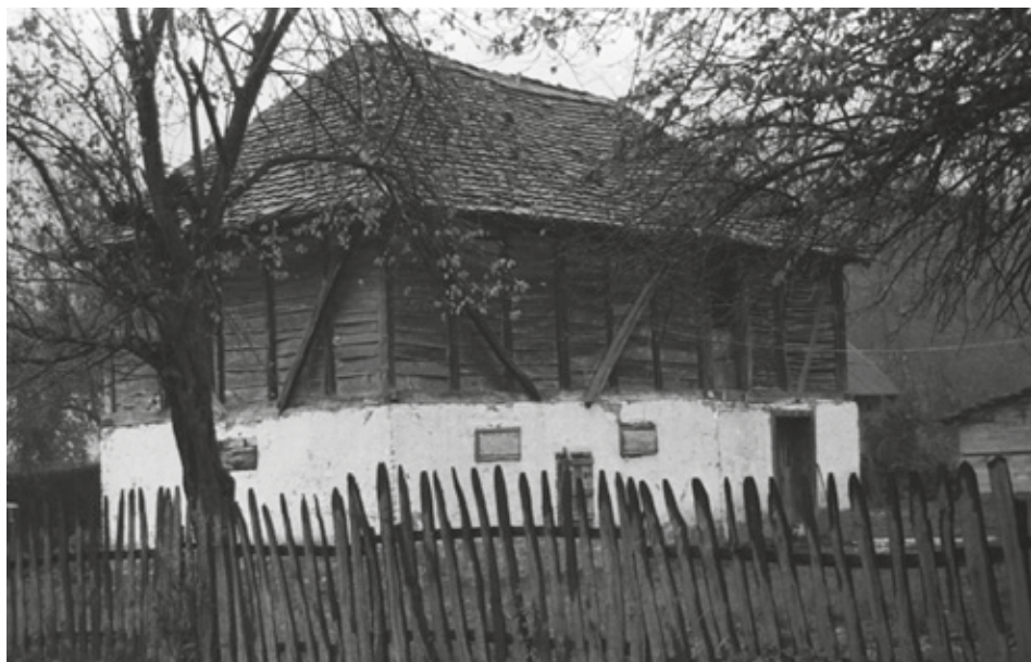
Прилој 20. Магаза на спрат са скелетом, косницима, испуном од дасака и четвороводним кровом
