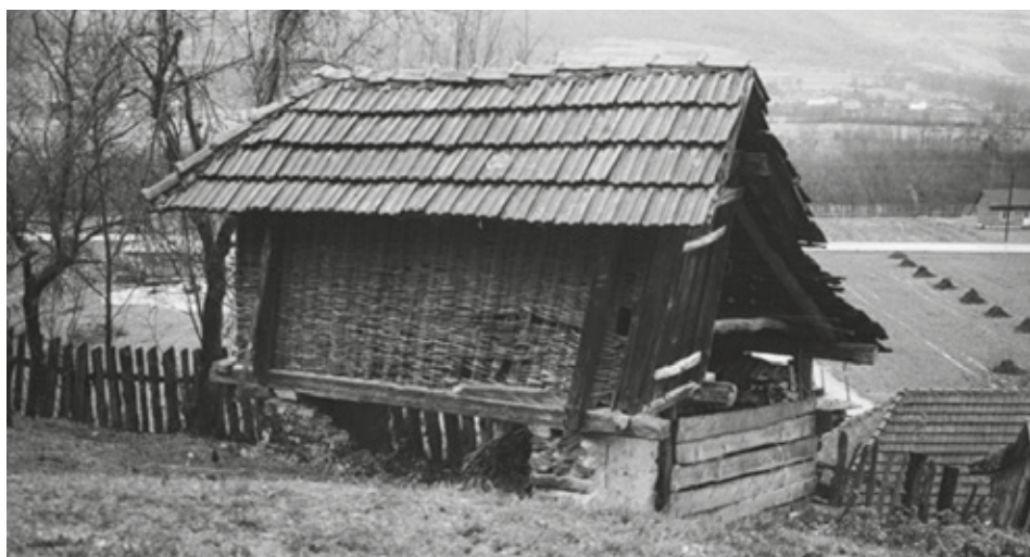
Прилој 23. Чардак са једноструким ступцима, преплетом од прућа
