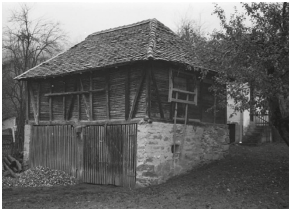
Прилој 19. Маџаза на ћелици затвореној са чела дрвеном оградом са делом са проветравањем за смештај кукуруза у клипу
