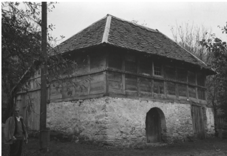
Прилој 21. Магаза на ћелици са двоструком оставом и корпусом на спрату у дрвеном скелету, испуном од талпи, и украшеним појасним укрућењем
