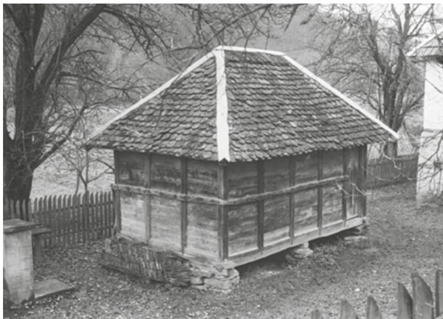
Прилој 17. Магаза са корпусом у скелету и испуном од брвана, ојачањем по средини висине корпуса ослоњена на темеље самце од тесаног камена
