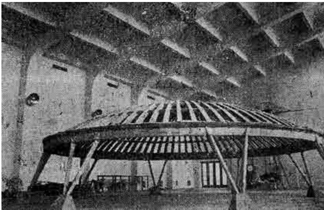
Сл. 7. Армиранобетонски модел Хале I у размери 1:10, Бранко Жежељ, 1956–57 ( Izgradnja XI , 1957, 3)
