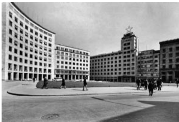
Сл. 7. Позиција залеучене фасадне конструкције према тргу
