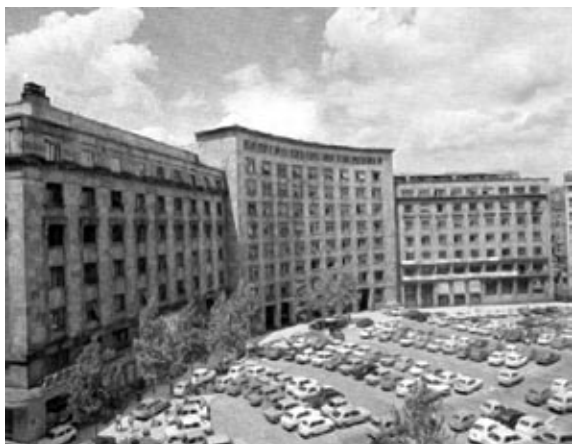
Сл. 6. Птероидна конструкција главне фасаде
